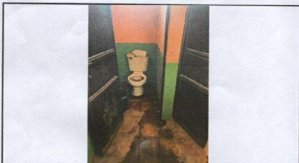
Foto 3: Reparacion de sistema de drenaje
