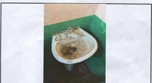
Foto 4: Sustitucion de lavamanos
