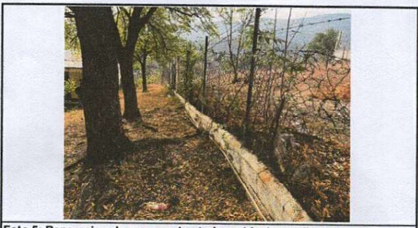
Foto 5: Reparacion de muro perimetral con block y malla galvanizada.
