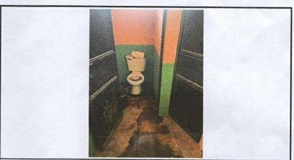
Foto 6: Sustitucion de tazas sanitarias
