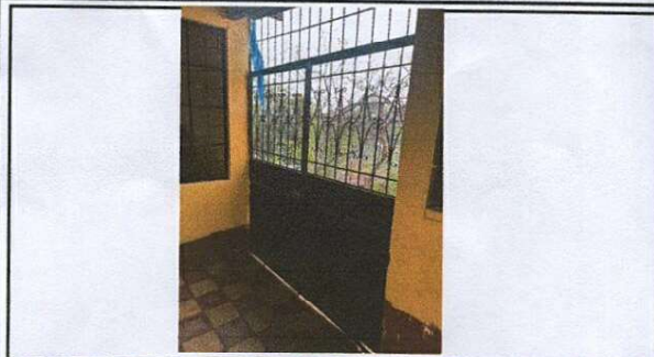
Foto 1: Sustitucion, fabricacion e instalacion de porton de metal con tubo de 1 1/2 chapa
